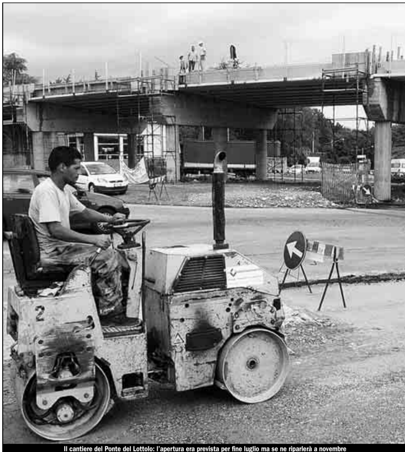
Il cantiere del Ponte del Lottolo: l'apertura era prevista per fine luglio ma se ne riparerà a novembre
