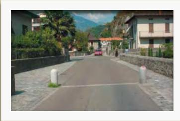
La piattaforma deve essere realizzata con materiali facilmente sostituibili ed adatti ad una elevata usura (asfalti o autobloccanti in cls.).
