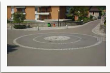
All'ingresso della strada, per conseguire una reale riduzione della velocità e sottolineare il passaggio verso un differente ambito è necessario realizzare "porte d'accesso" al viale attraverso l'istituzione di un'isola spartitraffico centrale che interrompa la continuità visiva dell'asse stradale facendo così percepire il cambiamento a coloro i quali transitano lungo la piattaforma.
