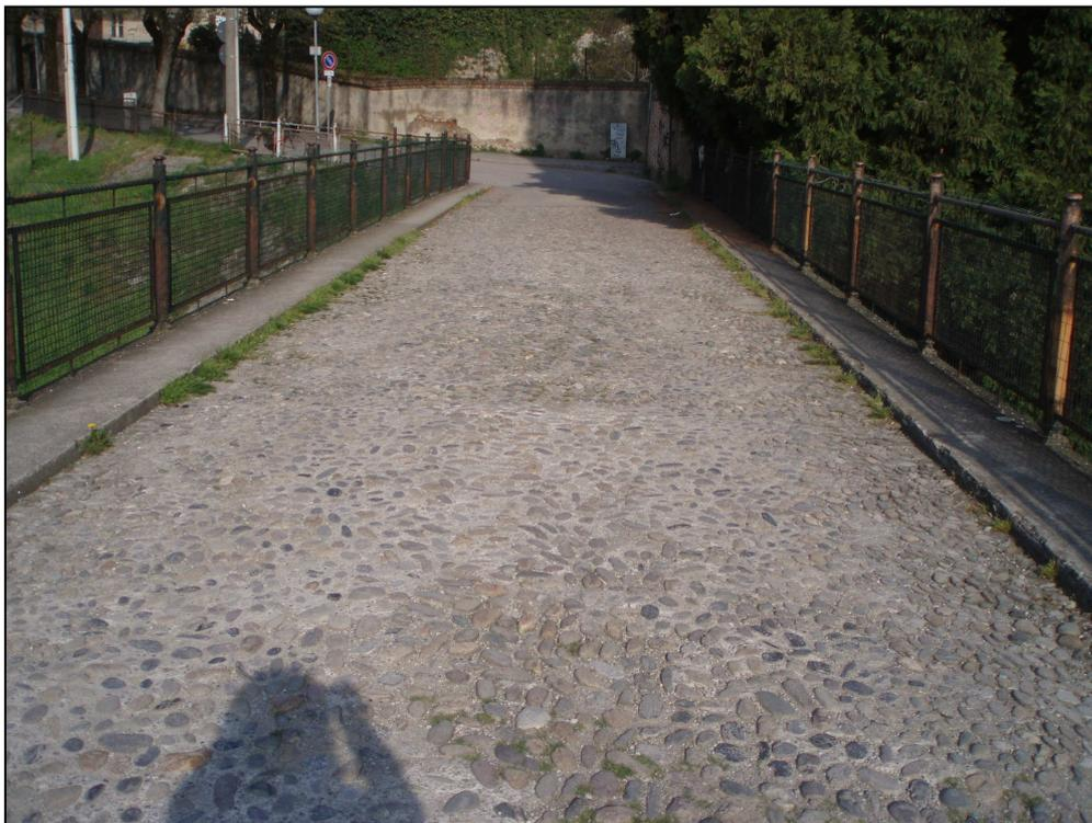
*Esempio di pavimentazione in acciottolato cementato*
