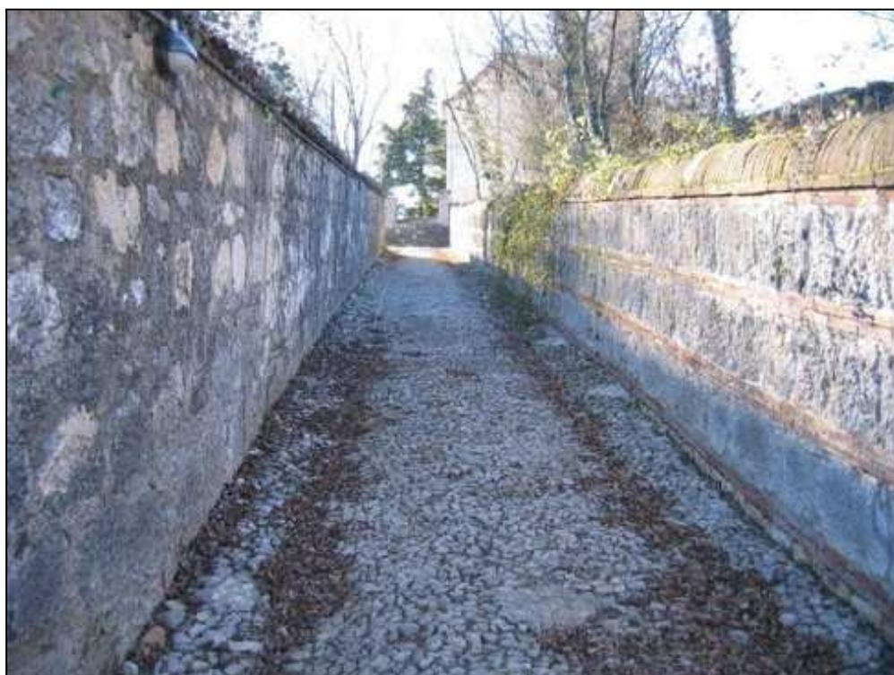
*Esempio di pavimentazione in ciottoli cementati*
