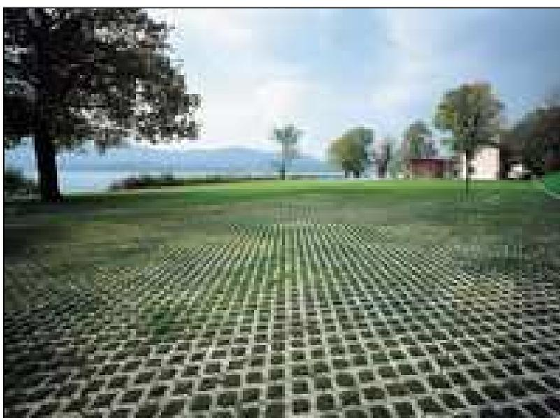
*Esempio di pavimentazione in autobloccanti di tipo drenante con vuoti inerbiti*
