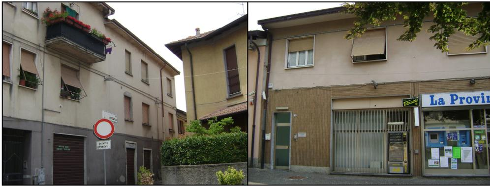
*Foto esemplificativa di serramenti e elementi di chiusura NON coerenti con il centro storico di Novedrate*
