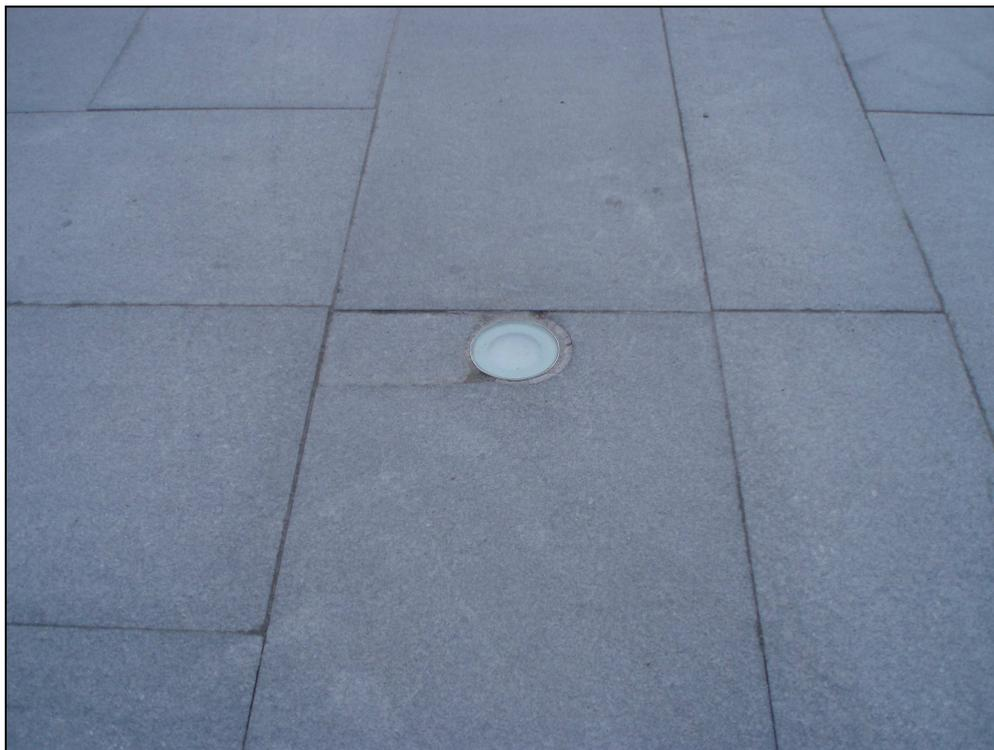
*Esempio di diffusore inserito nella pavimentazione per sottolineare un percorso*
