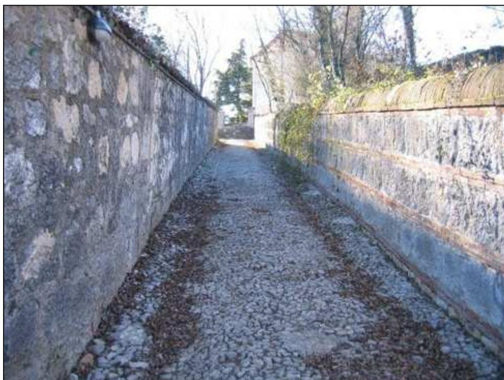
*Esempio di pavimentazione in ciottoli cementati*
