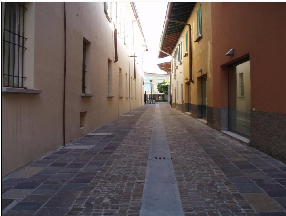
*Esempio di pavimentazione in porfido mista: cubetti per l'area carrabile, lastre per le aree pedonali laterali*
