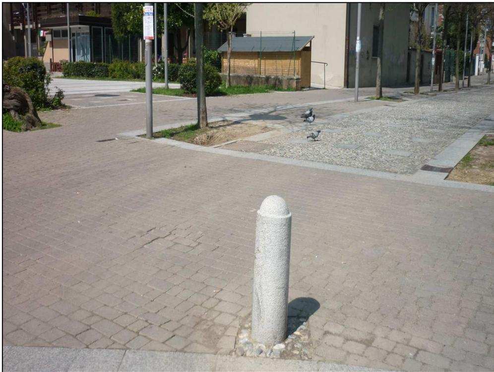
*Esempio di pavimentazione in masselli autobloccanti con trattamento di antichizzazione*
