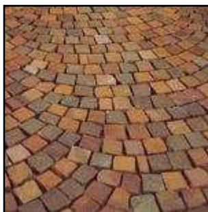
Posa ad arco
