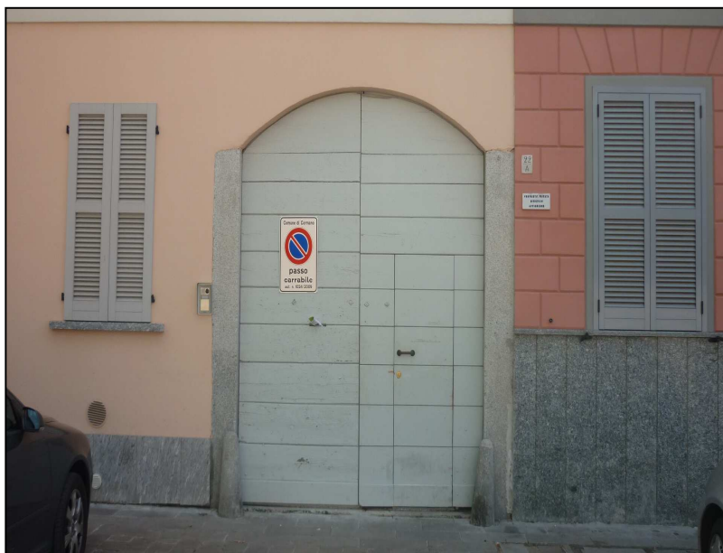
Esempio di classico portone in legno verniciato inserito all'interno di un portale con spalle in pietra e architrave a volta intonacato
