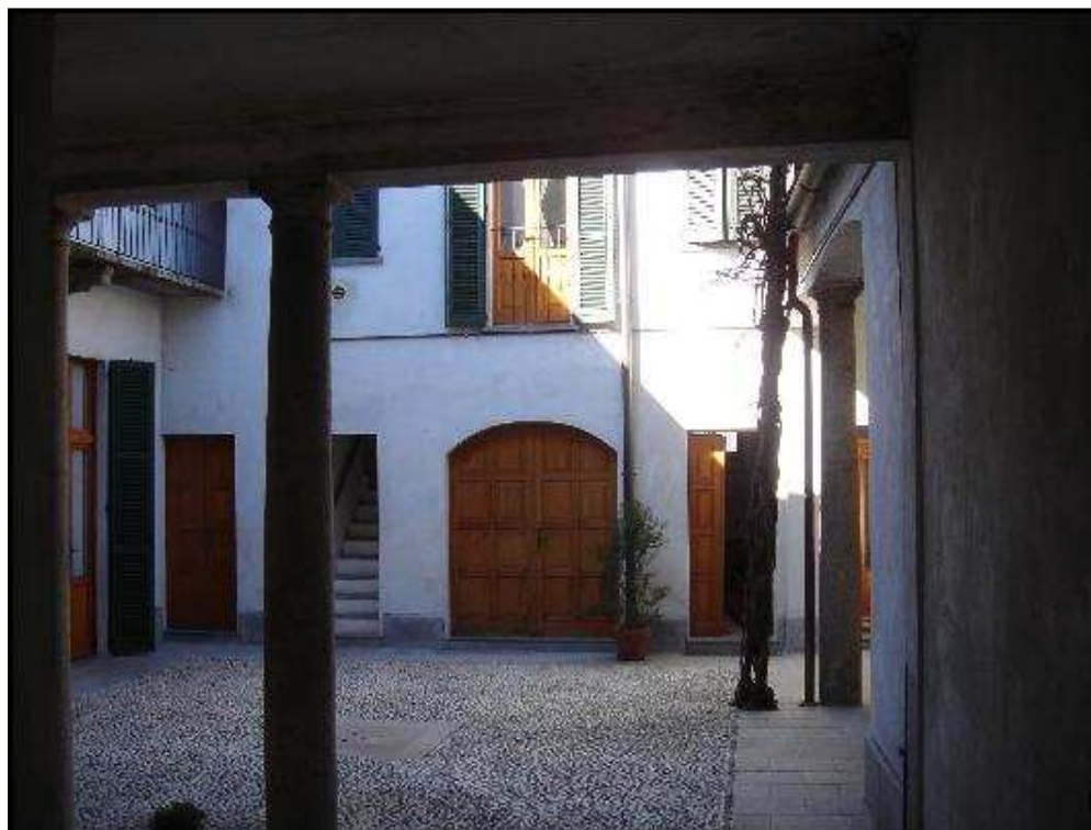
Cortile in acciottolato cementato al centro, pavimentazione in lastre di pietra limitrofe agli edifici
