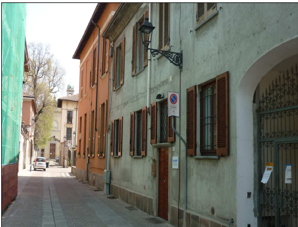
Esempio di facciata realizzata con finestre e persiane in legno a vista con inferriate integrate
