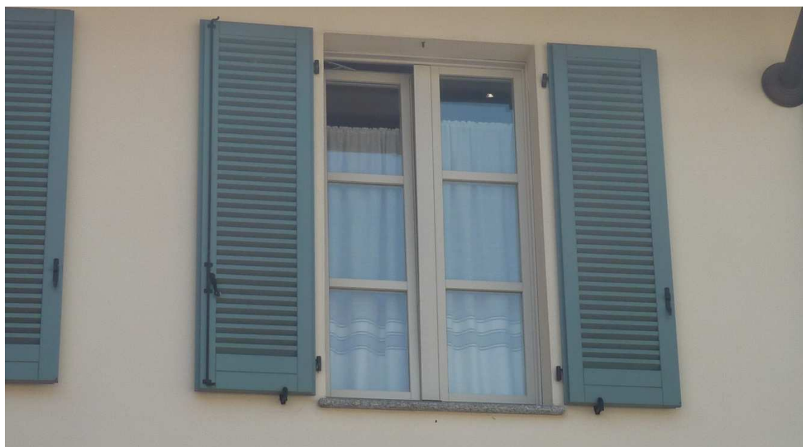
Esempio di serramento in legno verniciato con persiane in legno come sistema di oscuramento
