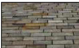
Posa di lastre a correre (larghezza fissa, lunghezza variabile)
