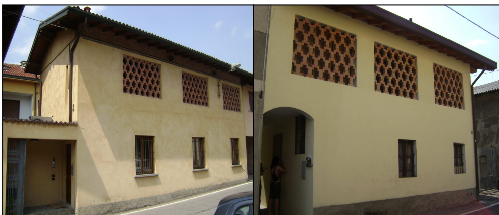
Foto esemplificativa di serramenti e elementi di chiusura COERENTI, RISTRUTTURATI DI RECENTE e particolarmente attenti al contesto del centro storico a Novedrate.
