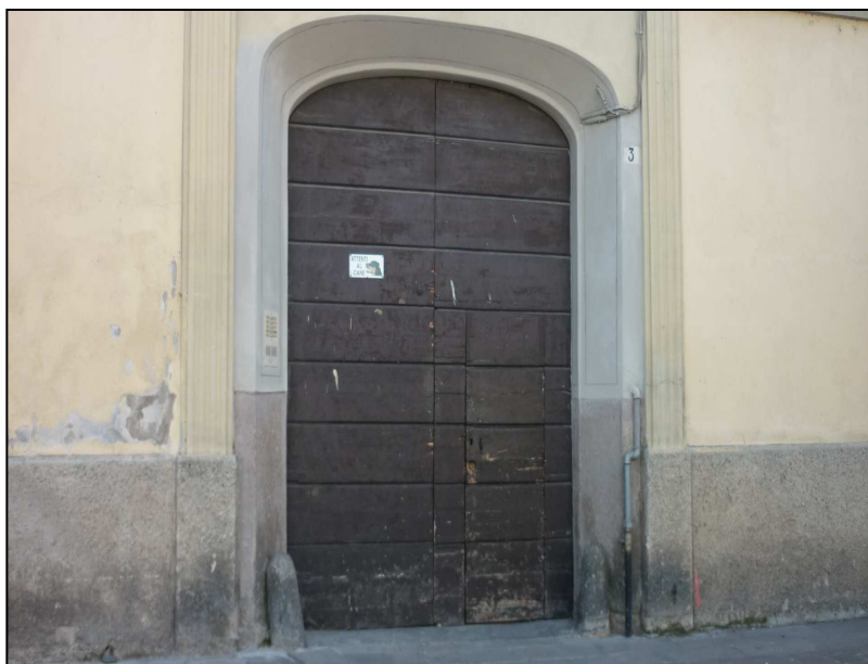
Esempio di classico portone in legno a vista inserito all'interno di un portale con spalle in pietra e architrave a volta intonacato
